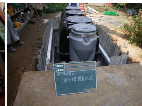
▶合併処理浄化槽
