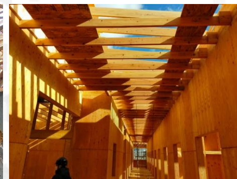
▶ 県産木材を活用した民間介護施設
